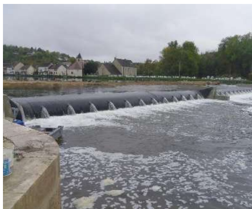
Barrage de Vauxrot ( Source : Ingérop)
