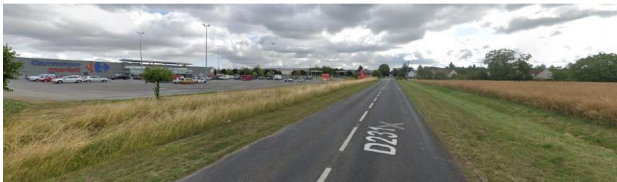
Entrée de Villers-Cotterêts par la D231, frange urbaine abrupte par la présence d'un centre commercial en limite d'openfield, sans transition végétalisée avec les cultures adjacentes (Source : Google Street View)
