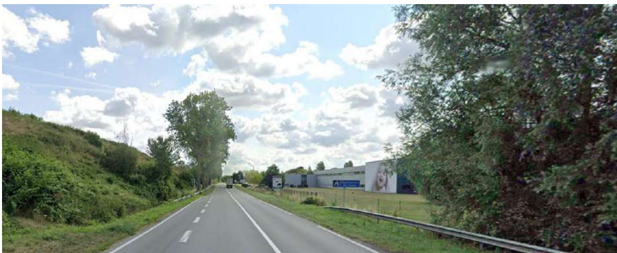
Entrée Nord-Ouest sur le territoire par la N31, qualitative du fait des alignements d'arbres et des panneaux signalant l'entrée dans le département de l'Aisne, malgré la présence de bâtiments d'activités mal insérés (Source : Google Street View)
